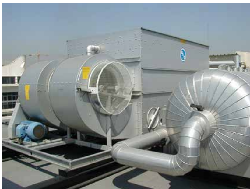
Figura 3: Condensador evaporativo
